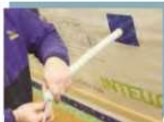
STOPPA fest eindrücken Stopfen bis zum Anschlag fest in das Leerrohr drücken.
