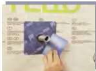
Verkleben Flächig auf zu dichtenden Untergrund führen, verkleben, fest anreiben. Fertig.
