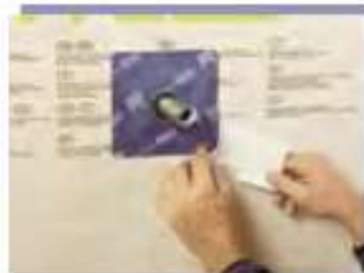
Ansetzen ROFLEX 20 über das Rohr ziehen. Trennpapier entfernen.
