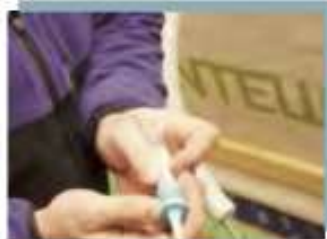
Loch einstechen STOPPA mit einem konischen Gegenstand (Nagel, Kugelschreiber oder Kartuschenspitze) durchstechen. Durchführung auf ca. 60 % des Kabeldurchmessers vorformen.
