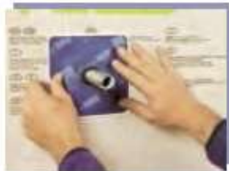
Vorbereiten Untergrund abfeilen, ggf. absaugen oder abwischen.
