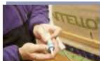
STOPPA Luftdichtungs-Stopfen für die luftdichte Ein- bindung von Kabeln und Leerrohren
